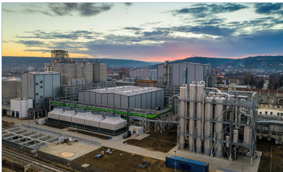
▲ Abb. 1: Eine Industrieanlage für die Produktion von Bioethanol der zweiten Generation. In dieser Anlage wird Ethanol mithilfe von Hefe aus Lignocellulose, etwa aus Stroh, produziert. Foto: Clariant.
